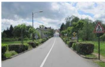
panneau EB10, accompagnées ou non par une coloration transversale (résine colorée par exemple), créent déjà une sensation de « rupture ». Une modification du type de marquage horizontal contribue également fortement à la modification de la typologie de la route.
